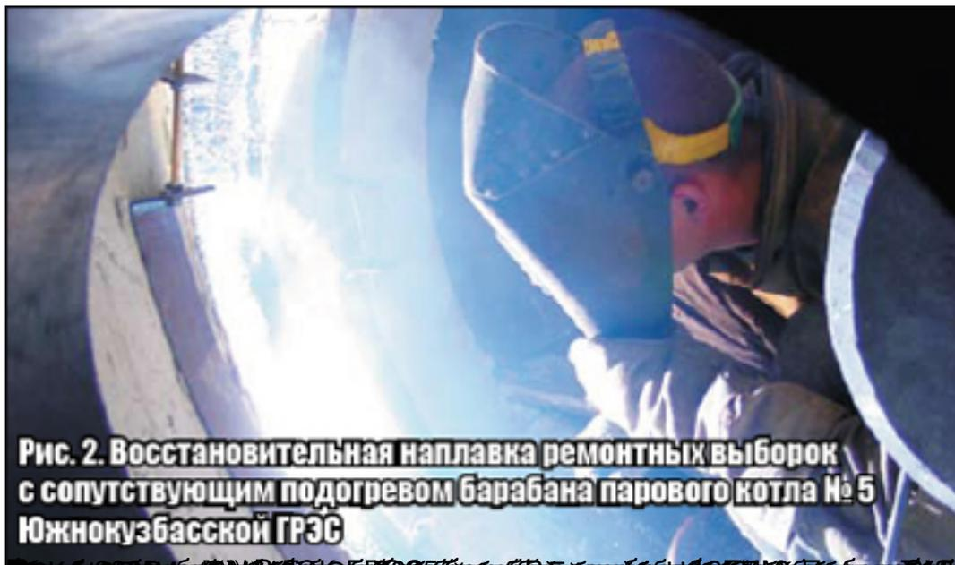
**Рис. 2. Восстановительная наплавка ремонтных выборок с сопутствующим подогревом барабана парового котла № 5 Южнокузбасской ГРЭС**
