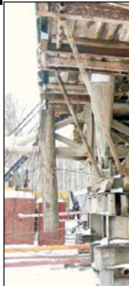
На буровой установке
